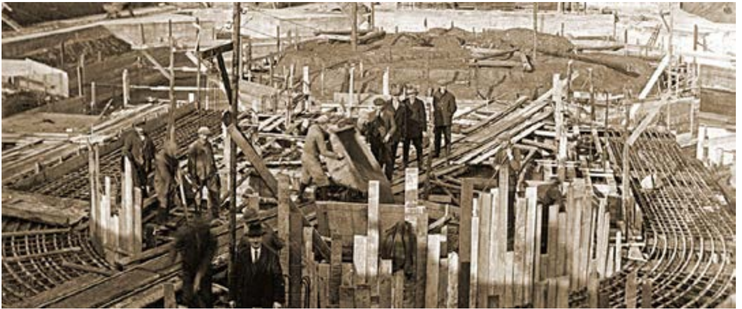
Gigantyczny plac budowy katowickiej katedry zdjęcie: Archiwum Archidiecezji Katowickiej
